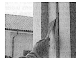
FASE 3: verifica verticalità serramenti
