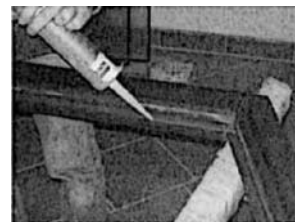
FASE 10: posizionamento coprifili
