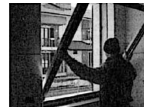
FASE 6: fissaggio telaio
