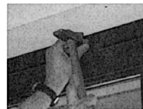
FASE 2: pulizia da residui intonaci e murari e imballaggi falsi telai
